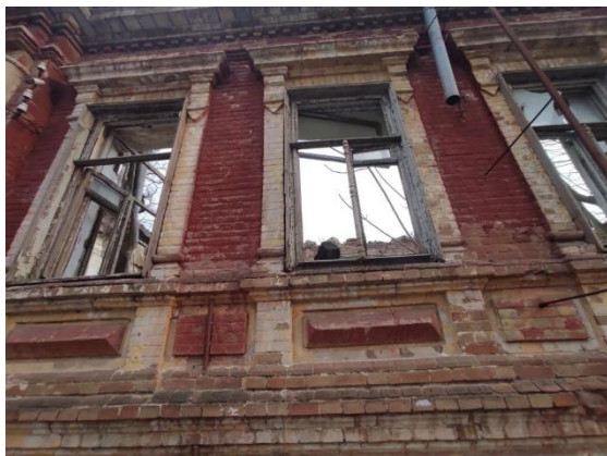
Фото 7 Общее состояние здания
