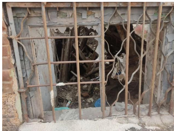
Фото 8 Общее состояние здания
